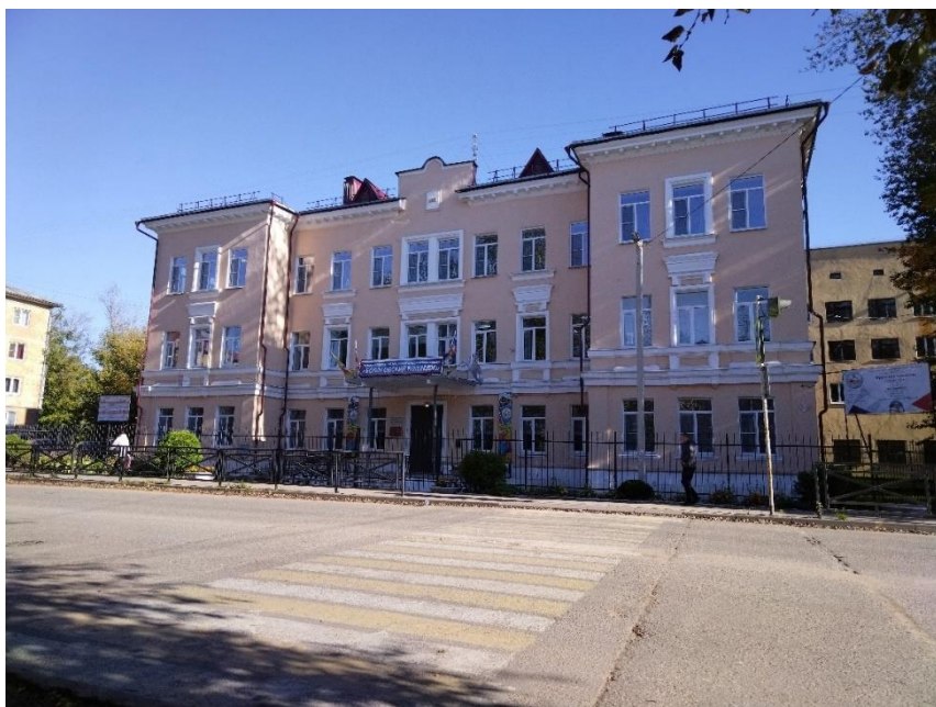
Главный учебный корпус
